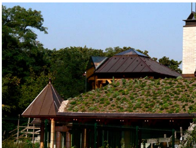
Niektóre partie dachu to „zielony dach”, porośnięty roślinnością
