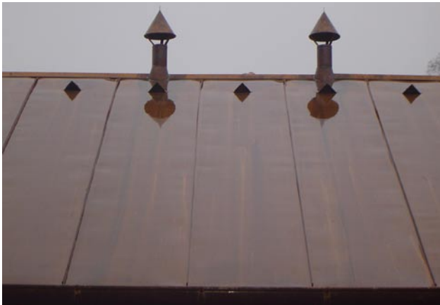
Fot. 8 Kominki wentylacyjne w kalenicy
