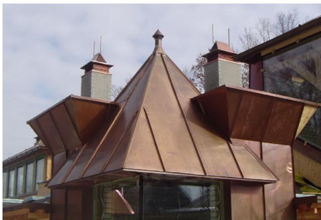
Fot. 2 Dach na narożniku
